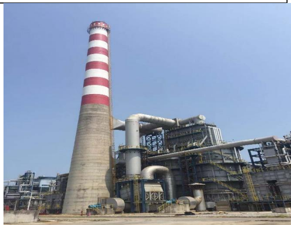
加氢裂化装置加热炉
