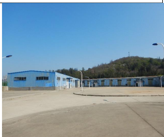
固废堆场全景照
