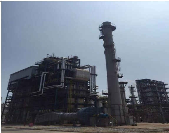
制氢装置转化炉
