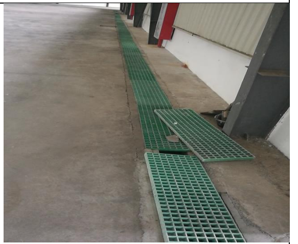
危废暂存间收集沟
