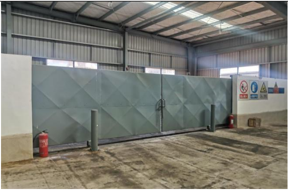
危险废物储存场所
