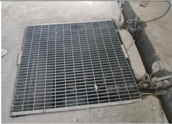
固废仓库内收集池
